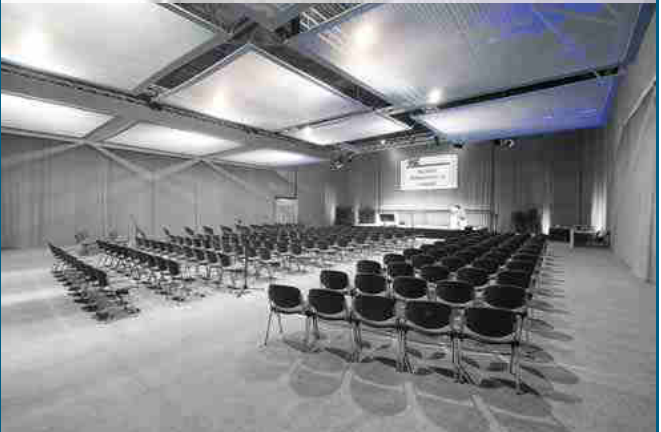
Deckenbespannung aus Sprinklerstoff
