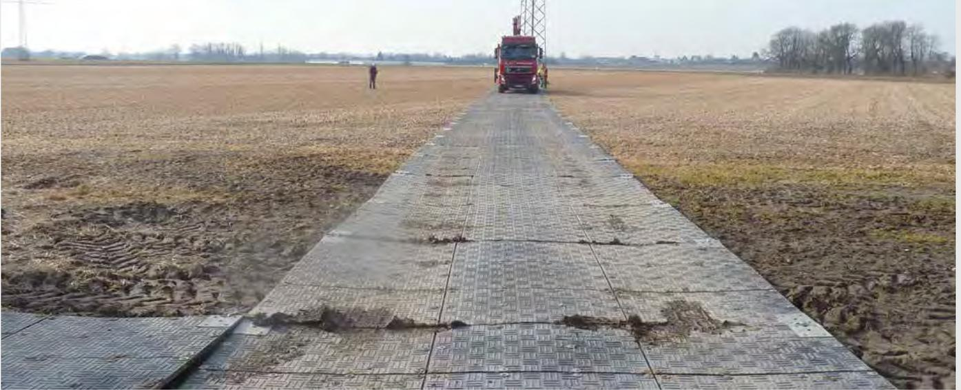
*PistEco Fahrstraßen verfügen über eine hohe Tragfähigkeit*
