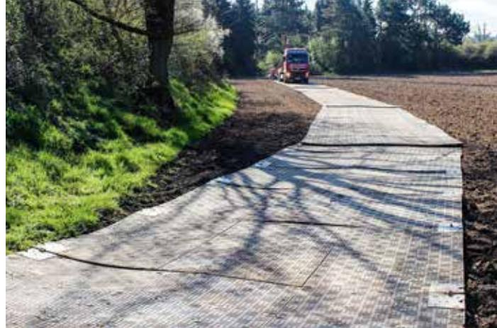
**PistEco** verwandelt nachgiebige Untergründe wie Wiesen- und Ackerflächen kurzfristig in hochbelastbare und befahrbare Straßen, Zufahrten und Montageplattformen. Die flexiblen Platten passen sich selbst unebenen Geländeverläufen optimal an und stellen eine sehr gute Traktion und Verteilung der Lasten sicher.
