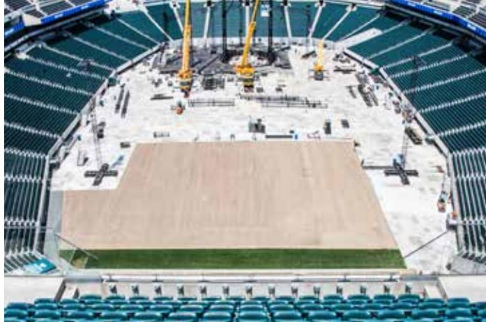
**Matrax Panels** sind ein leichtes Bodenschutzsystem aus Kunststoff, das in der Lage ist, schweres Gerät und große Menschenmengen zu tragen.
