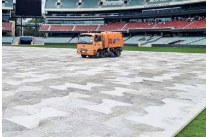
**I-Trac** lässt sich zu ebenen, hochstabilen Flächen verbinden und eignet sich für fast jeden Untergrund. Der I-förmige, vergleichsweise leichte Bodenschutz hält extremen Lasten stand. Zum Einsatz kommt er auf Baustellen und Events aller Art. So entstehen etwa mobile Baustraßen, Zufahrten und Fundamente im Rahmen von Stadionshows.
