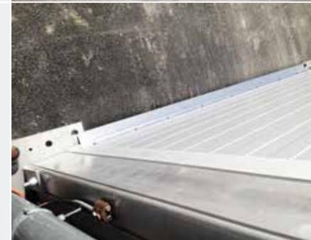
Verklebung mit Dichtband, klassischer L-Profilblech-Abschluss (siehe Abb.), Aufkantung mit Trapezprofilen
