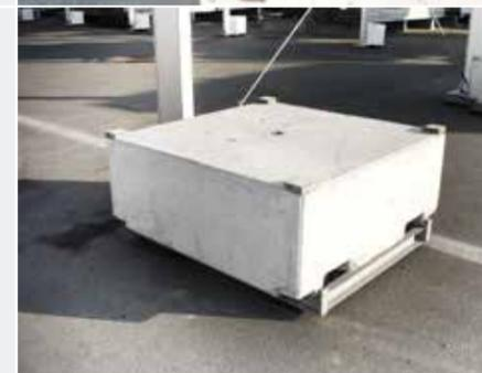
Ankerplatten der Halle werden mit Stahlaufnahmen und aufliegenden Betonelementen verschraubt
