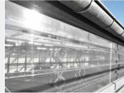
Bestehen aus PVC- oder Polycarbonat Eigenschaften: formstabil, wetterfest, schlagzäh, mit wetterseitiger Oberflächenvergütung Integration: vertikal oder horizontal in den Seiten, Vertikal im Dach oder als Lichtkuppel im First
