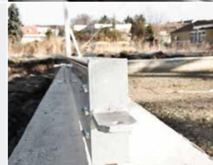
Einsatzbereiche: Montage der Verankerung auf geeigneten Bodenplatten, Einzelfundamenten und Streifenfundamenten möglich
