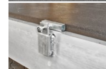
Arretierung Bühnen- platten Locking stage plates
